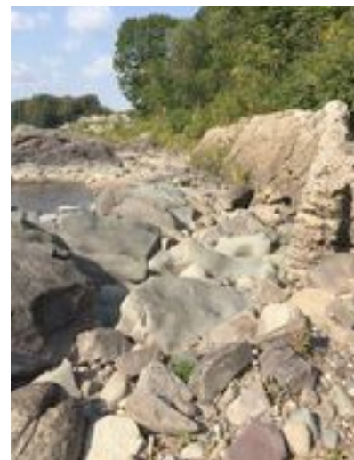
Les débris de pierre et de béton du moulin de la Chaussée Photo Marlène Pelchat
